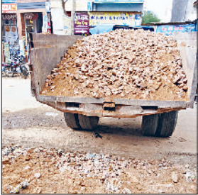
बहल। सड़क किनारे ब्लॉक लगाने के काम में रोड़ों के साथ डाली जा रही मिट्टी।
